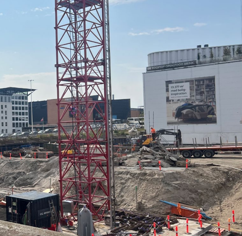
Niels Fennet står på Cabinn Copenhagen og skuer over sin byggeplads.
